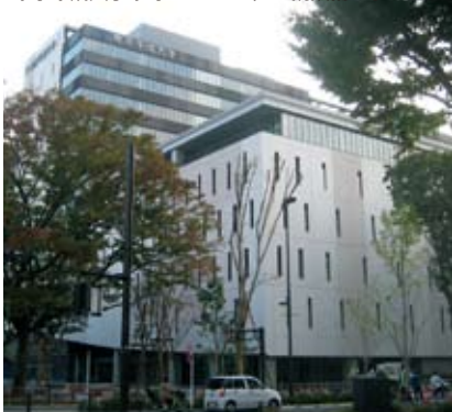
帝京平成大学中野キャンパス／空調設備工事
