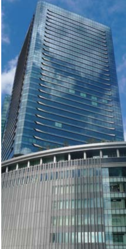
グランフロント大阪／空調・衛生設備工事
