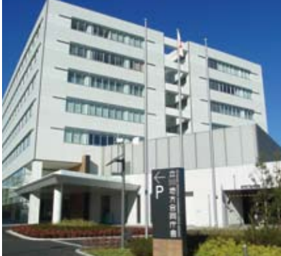
立川地方合同庁舎／空調・衛生設備工事
