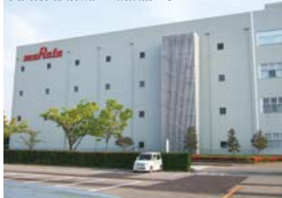
富山村製薬所／空調設備工事
