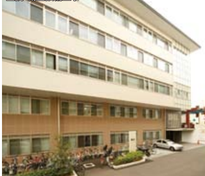
京都大学メディカルイノベーションセンター棟 空調・衛生設備工事
