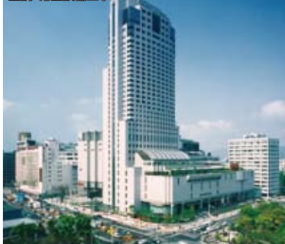
NTTクレド基町ビル(リーガロイヤルホテル広島) 空調・衛生設備工事
