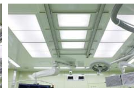
調光式LED照明内蔵型HEPAフィルタユニット
