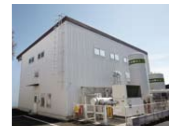
第二実験棟 超臨界CO 2 再生装置の検証・分析
