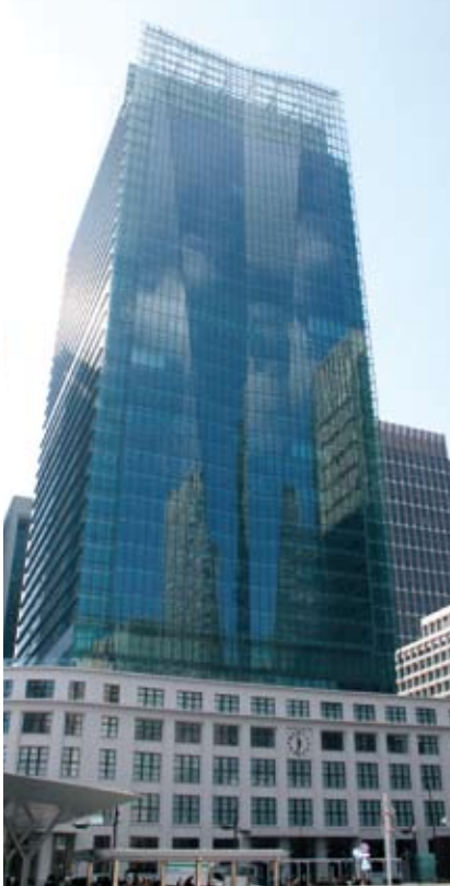
JPタワー／空調設備工事
