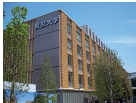
■ 帝京大学 板橋キャンパス大学棟 空調工事
