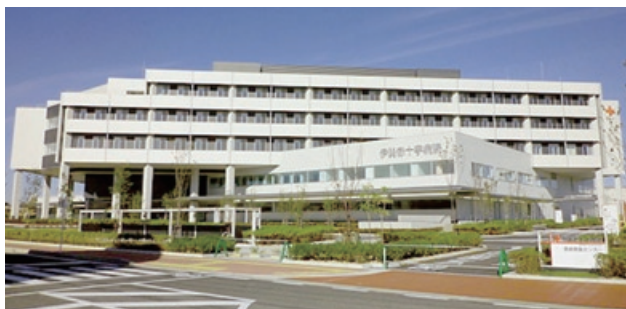
■ 伊勢赤十字病院 空調工事
