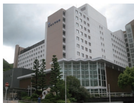
■ 長崎大学病院本館改修 電気工事
