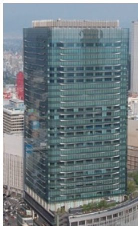
グランフロント大阪南館 空調工事
