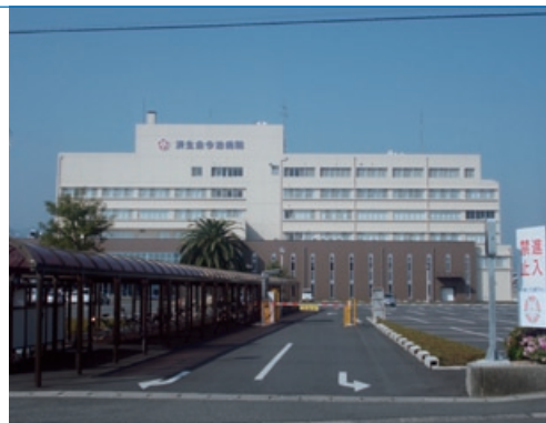
社会福祉法人恩賜財団 済生会今治病院 空調・水道衛生工事
