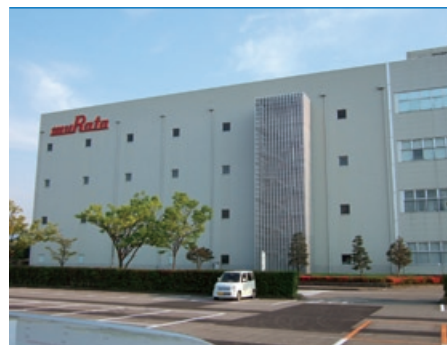
富山村田製作所 C1棟C2棟改修 空調工事
