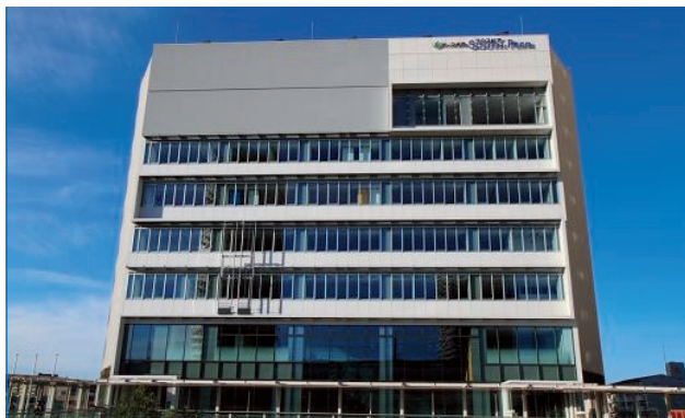
武蔵浦和駅第1街区第一種市街地再開発事業 電気工事
