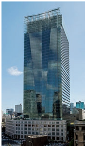
丸の内2丁目計画 空調工事
