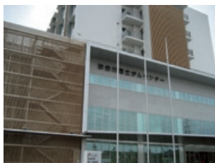
神奈川県立がんセンター 特定事業病院施設 空調・水道衛生工事
