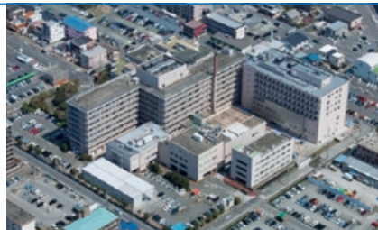
市立四日市病院 病棟増築既設改修 空調工事
