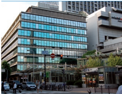
南海会館建替先行 電気・空調・水道 衛生工事
