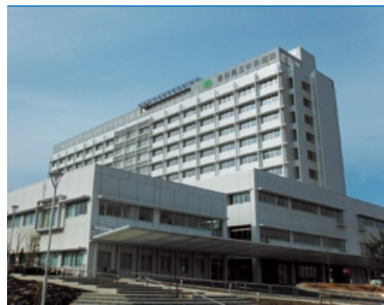
香川県立中央病院 空調工事
