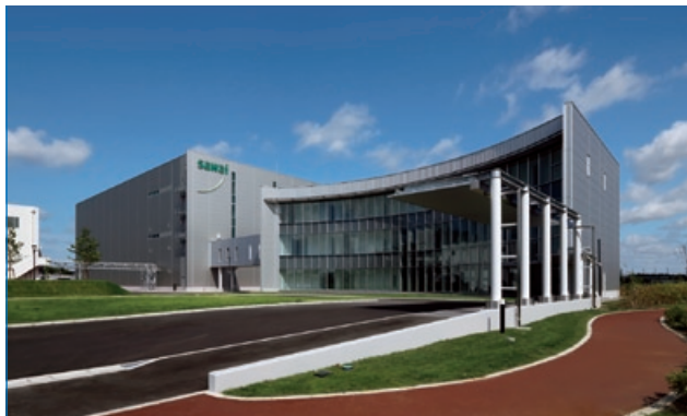
沢井製薬関東工場新工場 空調工事
