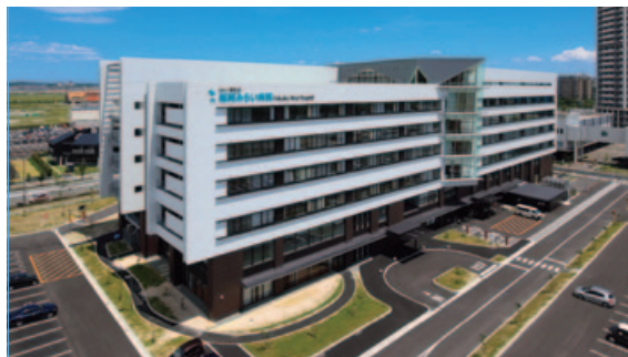
医療法人相生会福岡みらい病院 空調・水道衛生工事
