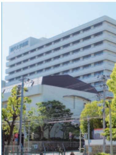
神戸大学医学部附属病院低浸襲総合診療棟 電気・空調・水道衛生工事
