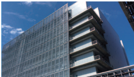
日亜化学工業新K-1棟 空調・水道衛生工事
