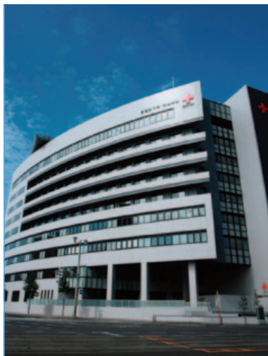
広島赤十字・原爆病院 空調工事
