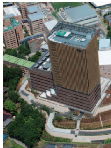
帝京大学八王子新校舎1期 空調工事
