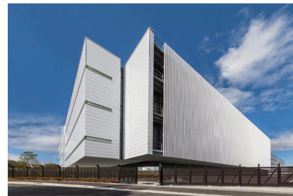
netXDC データセンター
