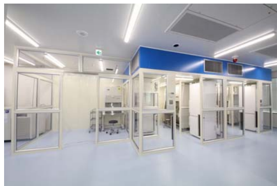
【エアバリアブースを用いた大部屋型CPF】
