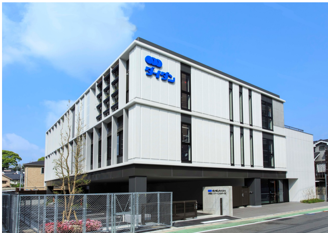
「ダイダン九州支社・スマートエネルギーラボ（エネフィス九州）」
