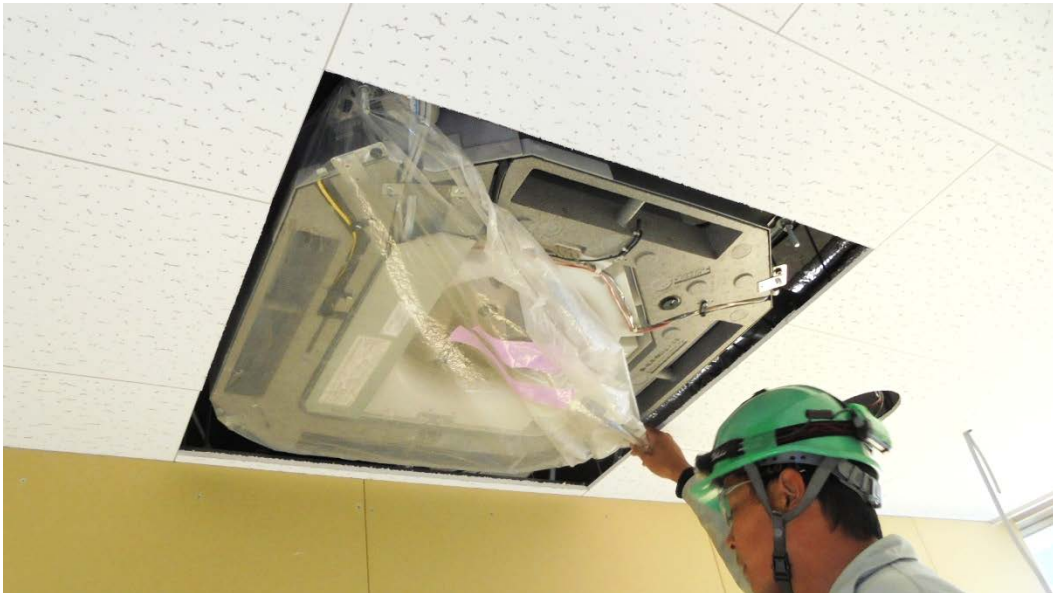
パッケージエアコン養生カバー「サットカバー」による養生の様子
