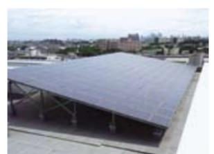
▲太陽光発電システム施工事例 シリコン系モジュール 100kWシステム
