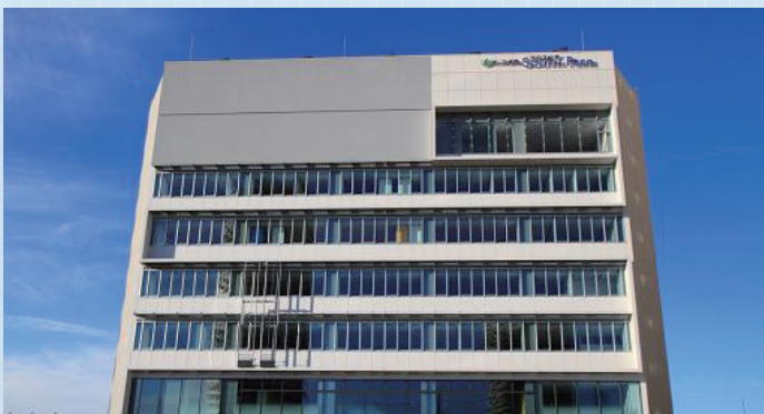
複合公益施設サウスピア 電気工事
