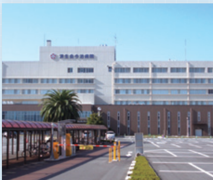
社会福祉法人恩賜財団済生会今治病院 空調・給排水衛生工事
