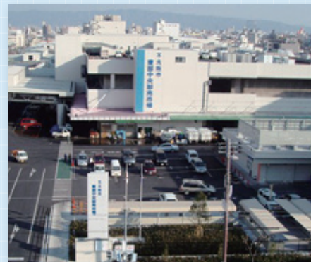
大阪市東部中央卸売市場 空調・給排水衛生工事
