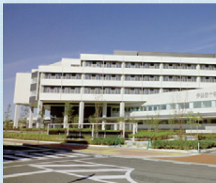
伊勢赤十字病院 空調工事
