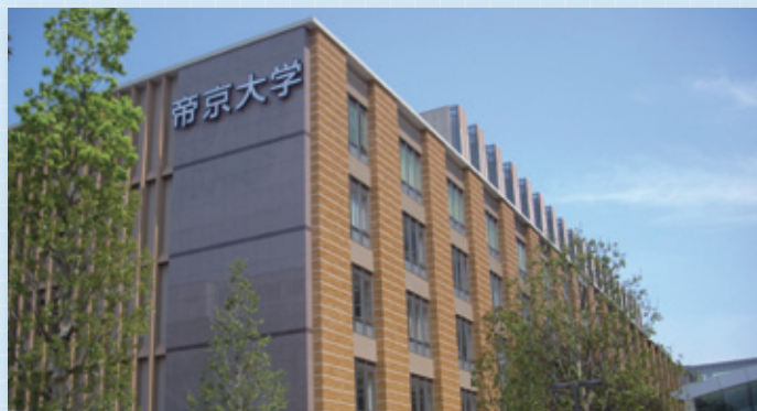
帝京大学板橋キャンパス大学棟 空調工事
