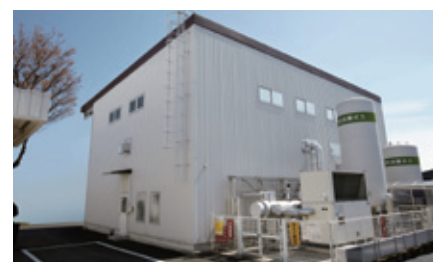
第二実験棟(超臨界CO 2 プラント)
