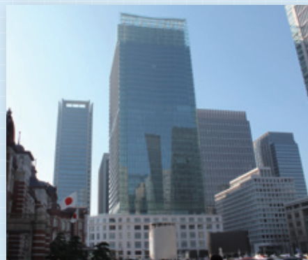
JPタワー 空調工事
