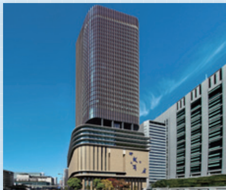
中之島フェスティバルタワー 空調工事
