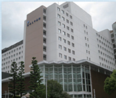
長崎大学病院本館 電気工事(改修)
