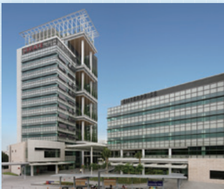
CREATE 電気・空調・給排水衛生工事
