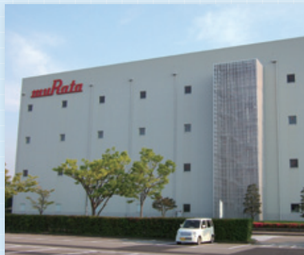
富山村田製作所C1棟C2棟 空調工事(改修)
