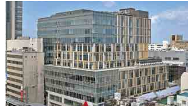
古町ルフル 【空調・給排水衛生設備工事】
