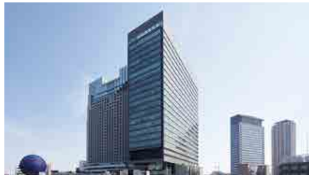
なんばスカイオ 【電気・空調・給排水衛生設備工事】
