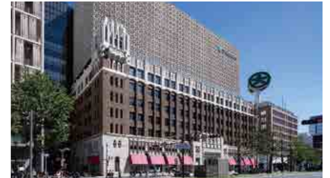
大丸心斎橋店 本館 【電気設備工事】
