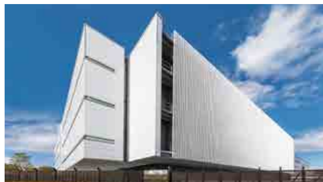
netXDC 三田第2センター 【空調・給排水衛生設備工事】
