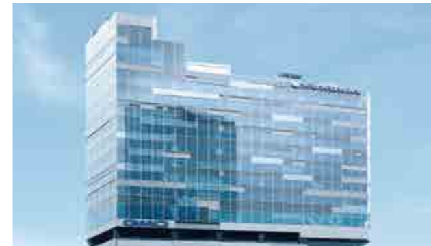
渋谷クラス 【空調・給排水衛生設備工事】
