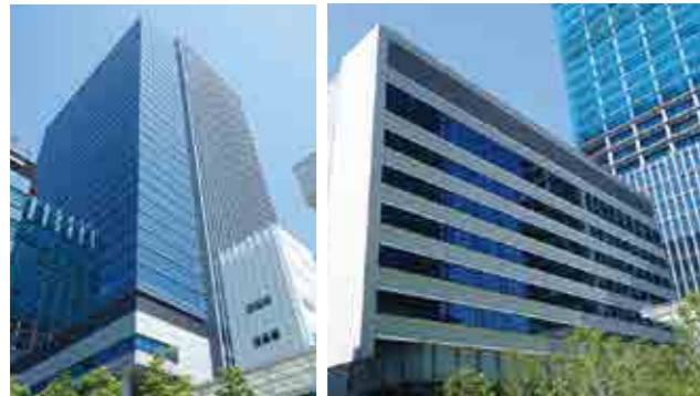
msb Tamachi 田町ステーションタワーS棟・プルマン東京田町 【空調設備工事】
