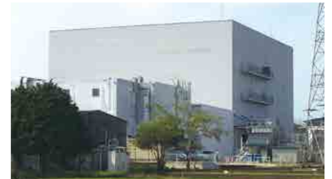
東海カプセル株式会社 本社工場 【空調・給排水衛生設備工事】
