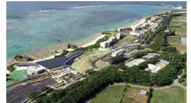
星のや沖縄 【空調・給排水衛生設備工事】
