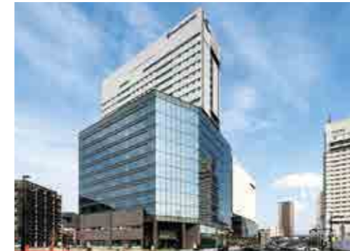
GRANODE広島 【電気・空調・給排水衛生設備工事】
