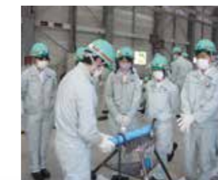
ダクト実技研修
