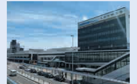
大阪国際空港ターミナルビル改修 【給排水衛生設備工事】
