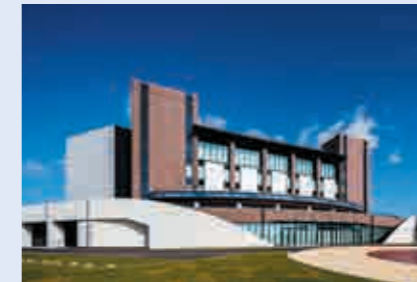
沖縄アリーナ 【空調設備工事】
