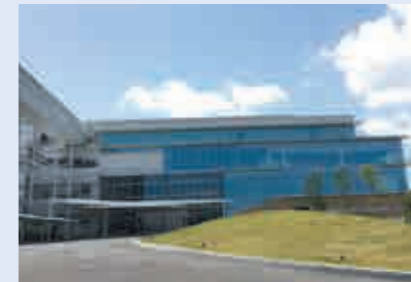
AGC横浜テクニカルセンターSE1棟 【空調・給排水衛生設備工事】
