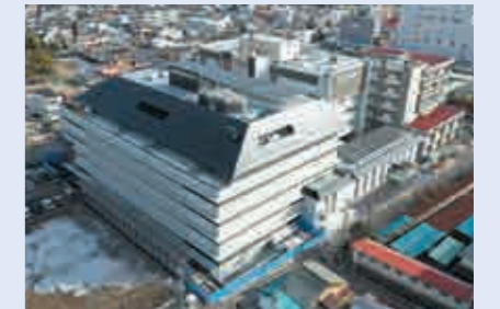
上田市新本庁舎 【空調・給排水衛生設備工事】
