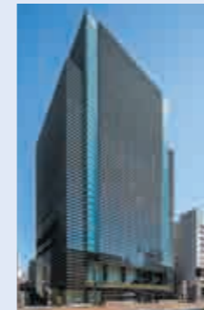
ひろぎん ホールディングス 本社ビル 【空調設備工事】
