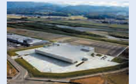
伸晃化学川北工場 【空調・給排水衛生設備工事】
