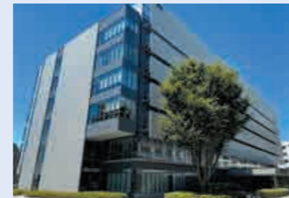
北里大学医療衛生学部A1号館 【電気・空調・給排水衛生設備工事】
