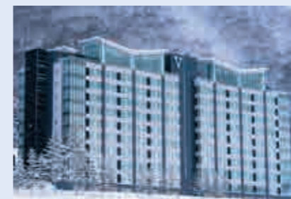
The Vale Rusutsu 【空調・給排水衛生設備工事】
