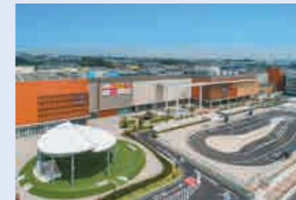
ららぼーと愛知東郷 【電気設備工事】
