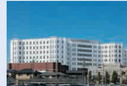
小牧市民病院 【空調・給排水衛生設備工事】
