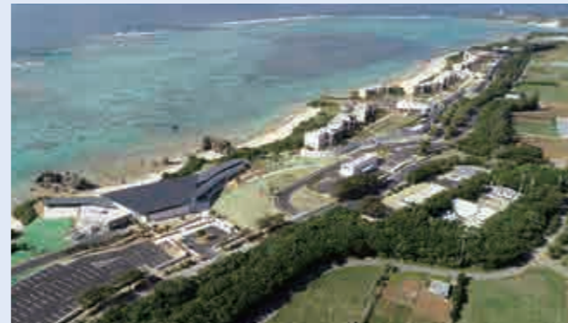
星のや沖縄 【空調・給排水衛生設備工事】
