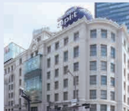
南海電気鉄道株式会社 南海ターミナルビル 【電気設備工事】
