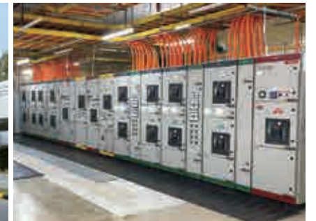
シンガポール チャンギ国際空港第2ターミナル[受変電設備更新工事]
