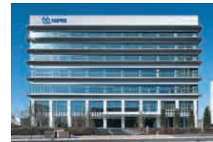
ニプロ株式会社本社ビル (大阪府) 【空調設備工事】
