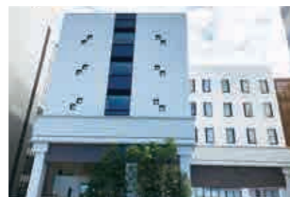
国立長寿医療研究センター (愛知県) 【電気設備工事】
