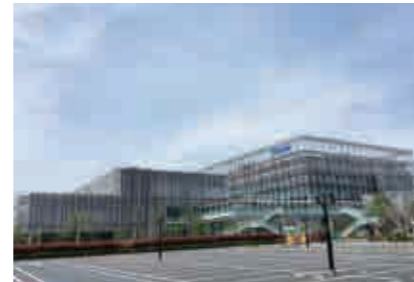
Kurita Innovation Hub (東京都) 【電気設備工事】
