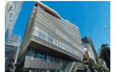
GRANBELL SQUARE (東京都) 【電気・空調・給排水衛生設備工事】
