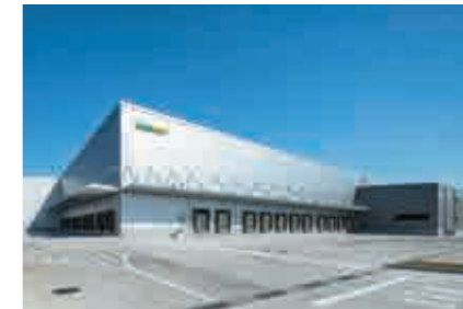
イオンネクスト株式会社菅田CFC (千葉県) 【空調・給排水衛生設備工事】
