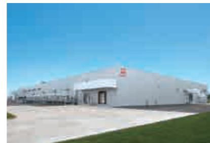
日本ハム北海道ファクトリー株式会社新工場 【空調・給排水衛生設備工事】
