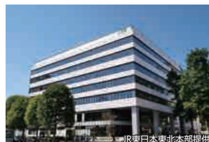
JR東日本東北本部 (宮城県) 【空調設備工事】
