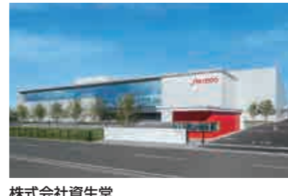
株式会社資生堂 福岡久留米工場生産設備 【給排水衛生設備工事】
