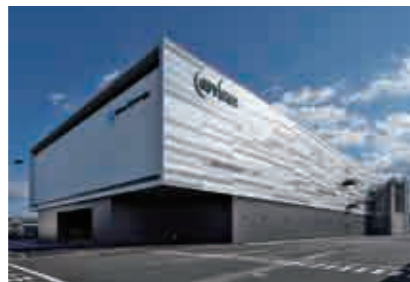
株式会社 GSユアサ 新工場 (京都府) 【給排水衛生設備工事】
