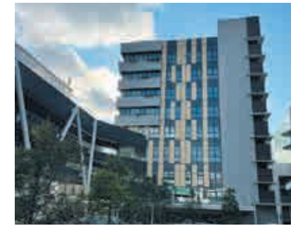
シンガポール MAH新築工事
