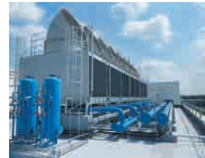
タイランド SIIX新築工事
