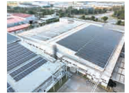
タイランド SAGINOMIYA太陽光電池設置工事
