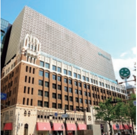
2019年 大丸心斎橋店本館
