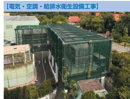
リゾートワールドセントーサ第2地冷設備機械室 (シンガポール)
