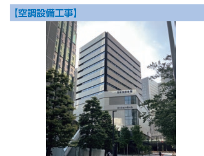
新日本消防会館 (東京都)
