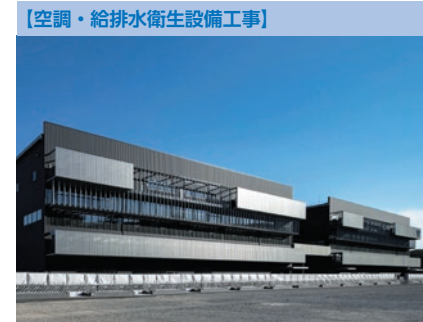
トヨタバッテリー株式会社 新居第二工場 (静岡県)
