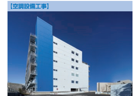
NRT12 データセンター実装 (千葉県)
