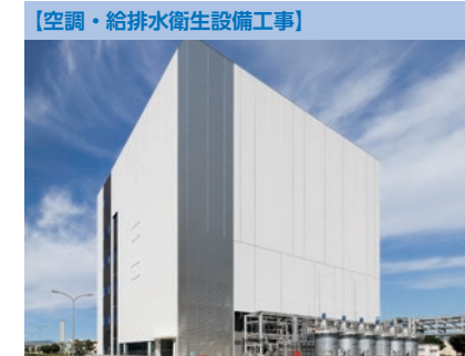
中外製薬工業株式会社 後期開発及び初期生産用合成原薬製造棟(FJ3) (静岡県)
