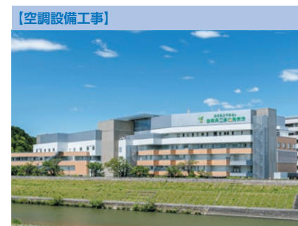
岐阜県立多治見病院 (岐阜県)
