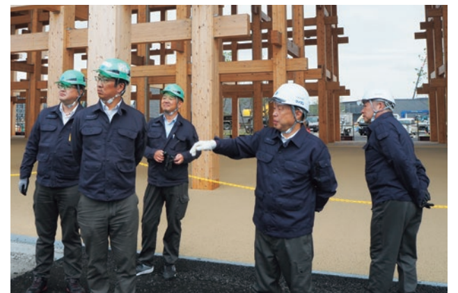
現場巡回する山中社長（右から2番目） 工事件名：2025年日本国際博覧会 熱供給業務 建物用途：エネルギーセンター 工期：2023年4月～2026年9月
