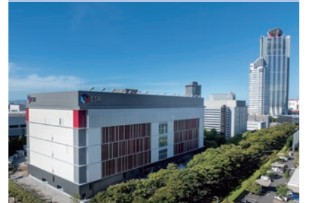
ESR南港OS1 データセンター (FO-1) (大阪府)
