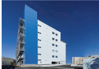
NRT12 データセンター実装 (千葉県)
