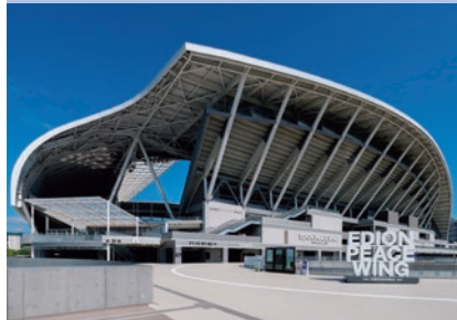
広島サッカースタジアム (広島県) 広島市提供
