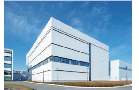
中外製薬株式会社 宇都宮工場 無菌注射剤製造棟 (UTA) (栃木県)
