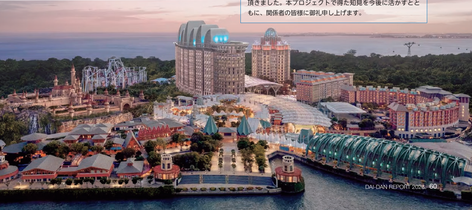
熱源設備工事を担当
