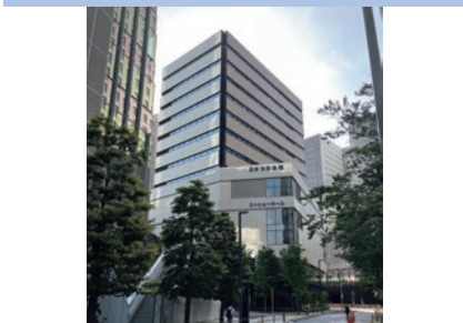
新日本消防会館 (東京都)
