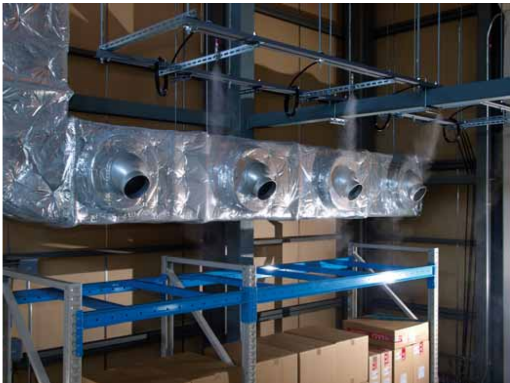
写真1 大空間倉庫での検証実験の様子
