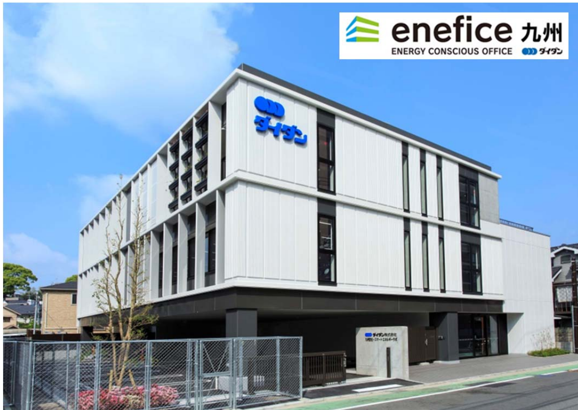
「エネフィス九州」完成写真（平成28年4月28日完成）
