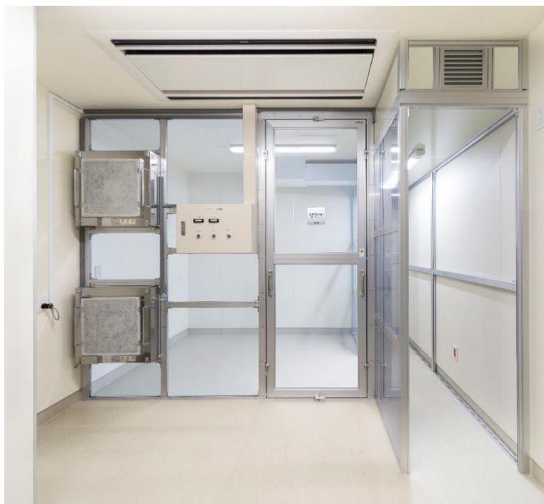
慶應義塾大学病院内の一般作業室に設置したエアバリアブース
