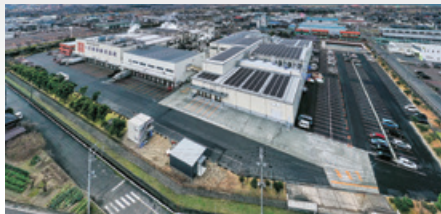
一正蒲鉾本社第二工場
