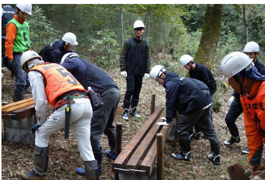
ベンチ設置のための杭打ち
