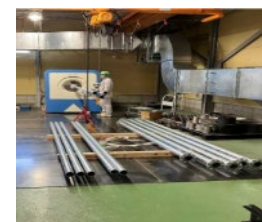
配管フレア加工
